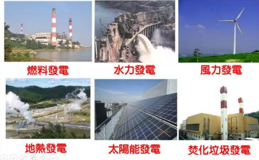
**燃料發電**是利用燃燒化石燃料產生蒸氣來推動發電機。燃燒燃料時會產生熱能，水受熱變成水蒸汽，水蒸汽可以推動渦輪，就可以產生電了。
